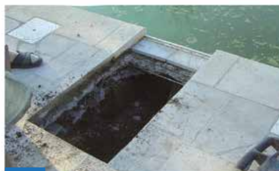
6 Fin des gros travaux
