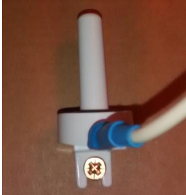
capteur de panneau solaire
