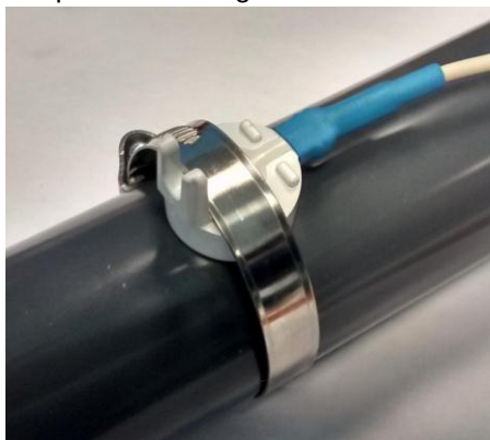
Montaje del sensor de temperatura del agua
