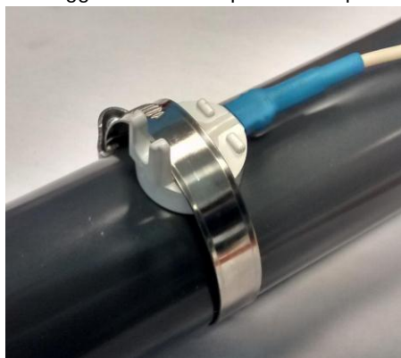
Montaggio sensore temperatura acqua
